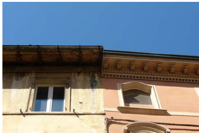
Fig.8: Case a schiera a tre livelli; accostamento tra due case a schiera con parete longitudinale in comune.
