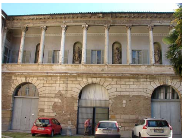
Fig.10: Esempi di prospetti su corte interna di palazzi con sistema di loggiato o portico-loggia sovrapposti .
