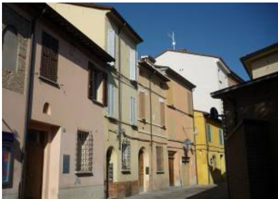
Fig.19: Esempificazione fotografica degli elementi localizzati nella mappa delle vulnerabilità e resistenze: corpi svettanti e allargamento delle aperture ai piani terreni.
