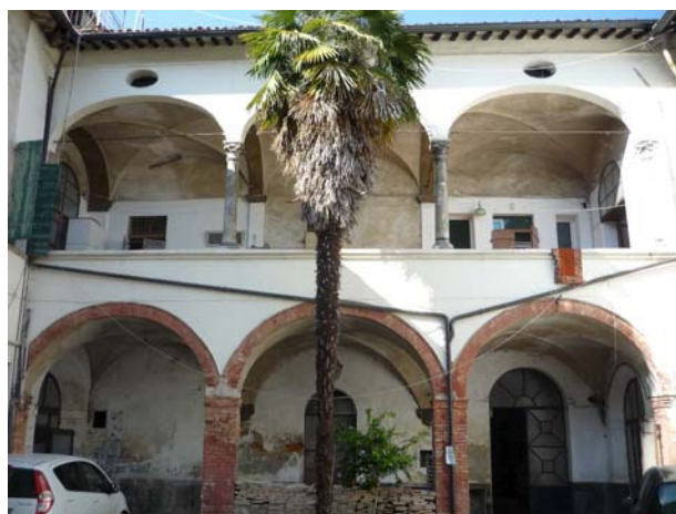
Fig.10: Esempi di prospetti su corte interna di palazzi con sistema di loggiato o portico-loggia sovrapposti .
