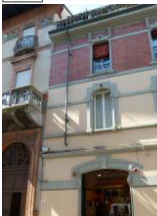
Fig.20: Esempificazione fotografica degli elementi localizzati nella mappa delle vulnerabilità e resistenze: disallineamento delle quote di orizzontamento, disallineamento verticale delle aperture, cimasa di spessore ridotto.
