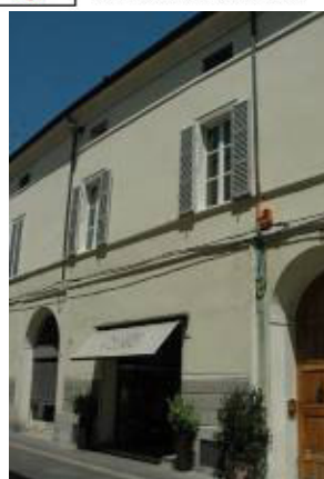
Fig.20: Esempificazione fotografica degli elementi localizzati nella mappa delle vulnerabilità e resistenze: disallineamento delle quote di orizzontamento, disallineamento verticale delle aperture, cimasa di spessore ridotto.
