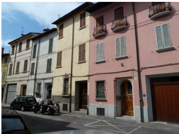
Fig.8: Case a schiera a tre livelli; accostamento tra due case a schiera con parete longitudinale in comune.
