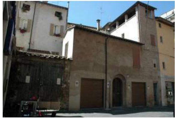
Fig.19: Esempificazione fotografica degli elementi localizzati nella mappa delle vulnerabilità e resistenze: corpi svettanti e allargamento delle aperture ai piani terreni.
