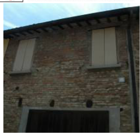
Fig.20: Esempificazione fotografica degli elementi localizzati nella mappa delle vulnerabilità e resistenze: disallineamento delle quote di orizzontamento, disallineamento verticale delle aperture, cimasa di spessore ridotto.
